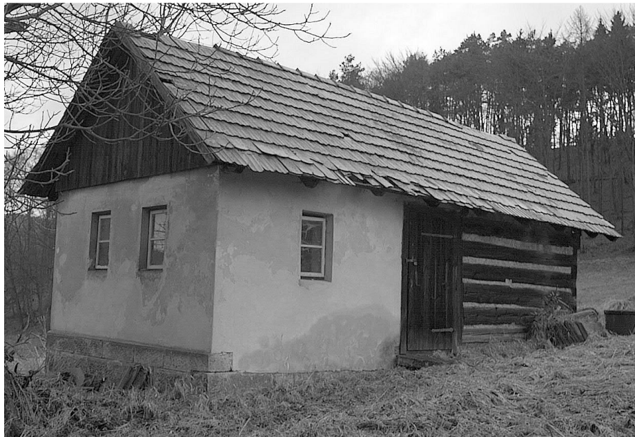
“Havlíkova” sušárna. Pohled na vyzděnou přípravnu. Pravá část objektu je roubená a sloužila jako sušiči komora. Stav k 12. 2. 2002. Foto archiv autora.
