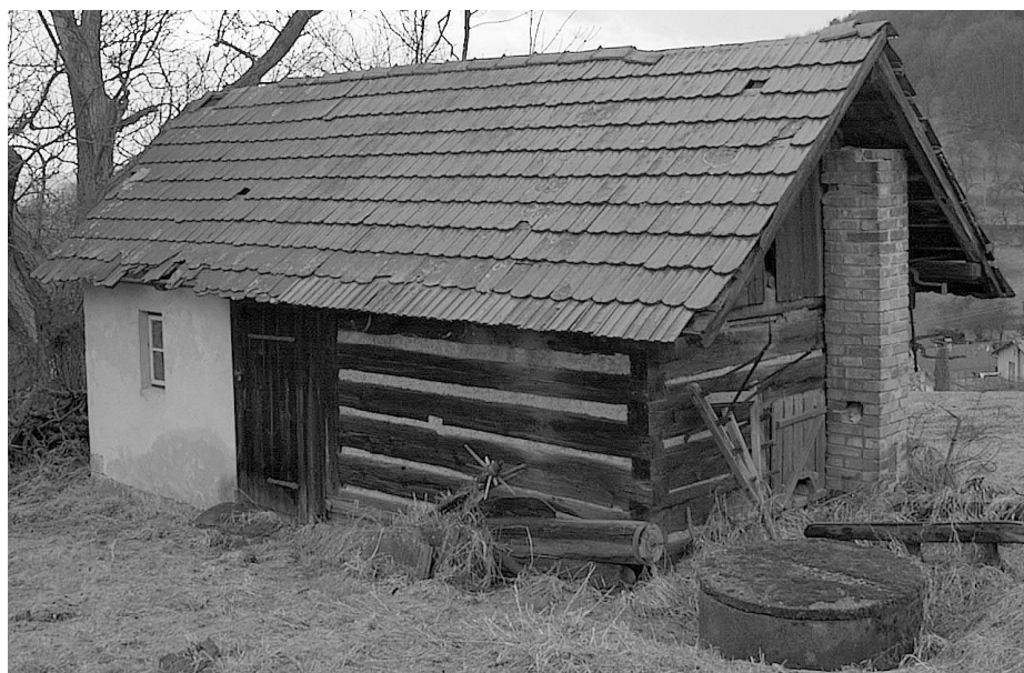
“Havlíkova” sušárna. Pohled na ohniště sušiči komory s venkovním komínem. Stav k 12. 2. 2002. Foto archiv autora.
